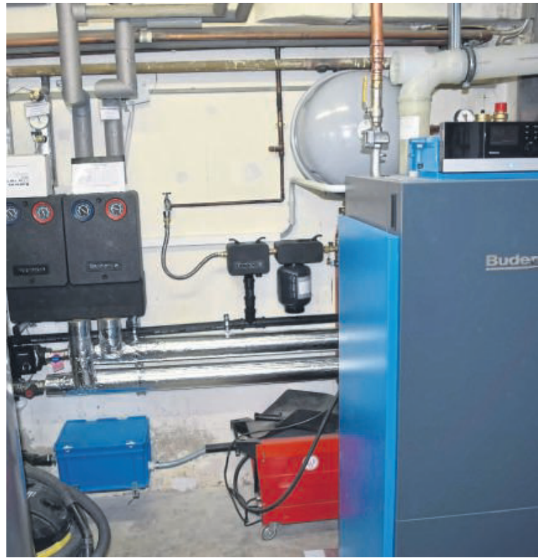
Ausgetauscht wurde die Heizungsanlage für die untere Etage und das Vereinszimmer.
