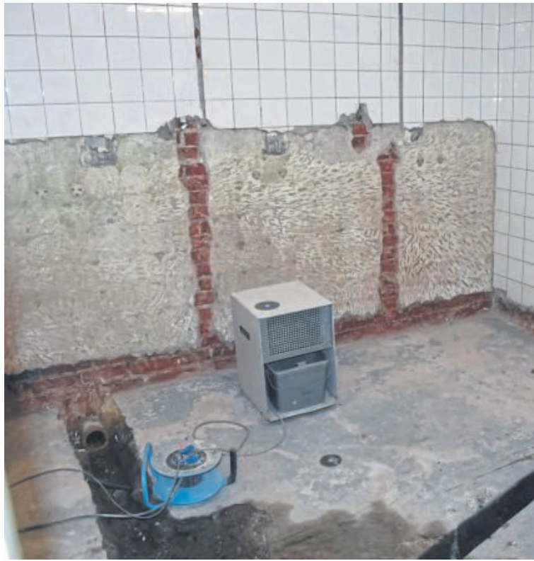
Die Komplett-Modernisierung der Herrendusche , die demnächst barrierefrei sein wird, ist in vollem Gang.
